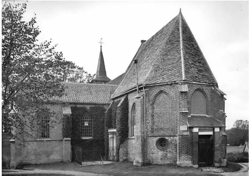
De afdekplaat van de grafkelder is nog zichtbaar: Gelders Archief.
